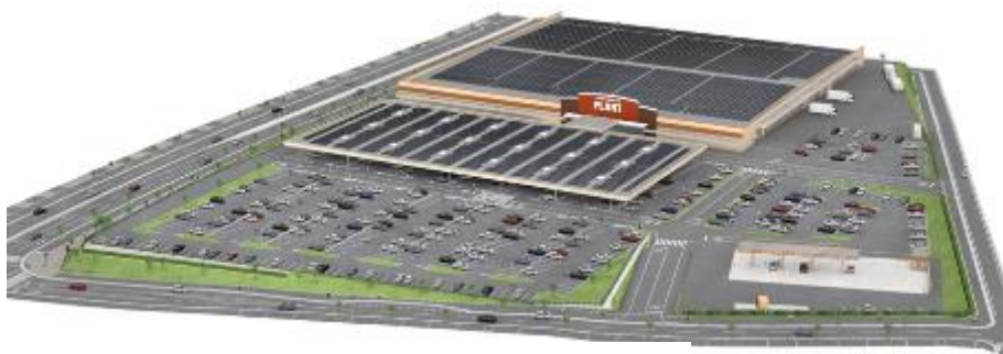
屋根付き駐車場、ガソリンスタンド
